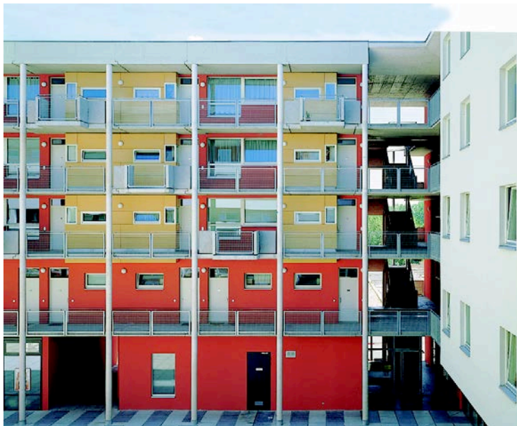
18. Fassade Ost, Minilofts und Seniorenwohnen
