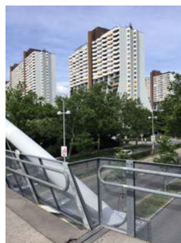
6. Straßenraum Alt Erlaa an der Anton Baumgartnerstraße
